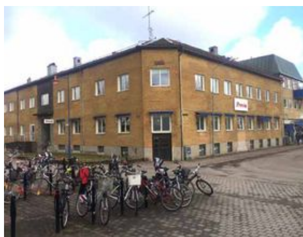
Byggnaden uppfördes 1868, enligt skylten på fasaden.
